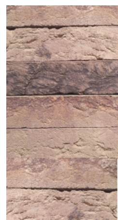
code: MW4 metselwerk: HV-WF kleur: rood-zand type: 6N32
