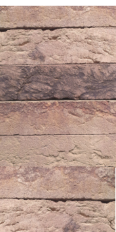
code: MW4 metselwerk: HV-WF kleur: rood-zand type: 6N32
