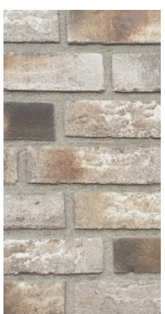
code: MW2 metselwerk: HV-WF kleur: (licht)bruin-grijs type: 12N302
